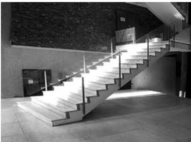
Prima rampa di scale a sbalzo della Casa del Girasole. / First flight of stairs, cantilevered, of the 'Sunflower'.
